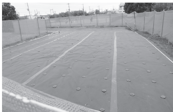
防草シートで養生された与野中央公園整備予定地
