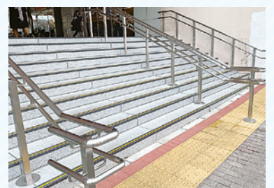
与野本町駅東口の階段整備
