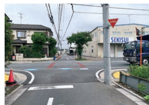
町谷本太線、町谷4丁目の交差点に横断歩道設置
